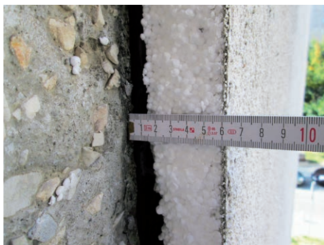
FOT. 9. Pomiar grubości odsunięcia termoizolacji od podłoża; fot. archiwum autora
