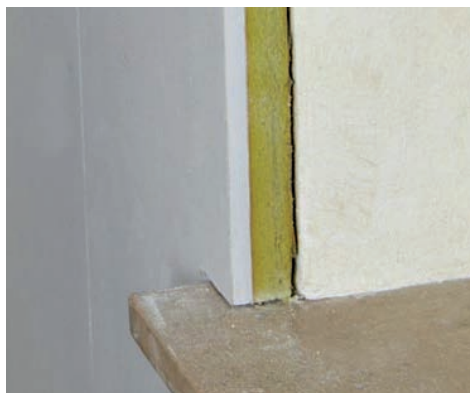
FOT. 3. Aerowetna jako izolacja od wewnątrz; fot.: Deutsche Rockwool Mineralwool [9]
