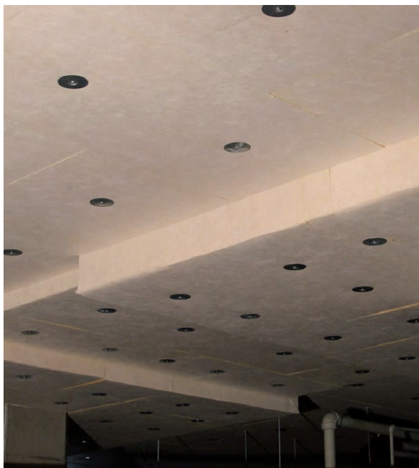
FOT. 2. Ocieplenie stropu pomiędzy pomieszczeniem mieszkальnym a piwnicą
