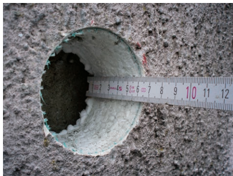
FOT. 8. Punktowy pomiar grubości ocieplenia; fot. archiwum autora
