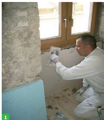
FOT. 1–2. Zastosowanie izolacji z aerożelu w miejscu pocienienia ściany zewnętrznej; fot.: EnergieCluster [8]
