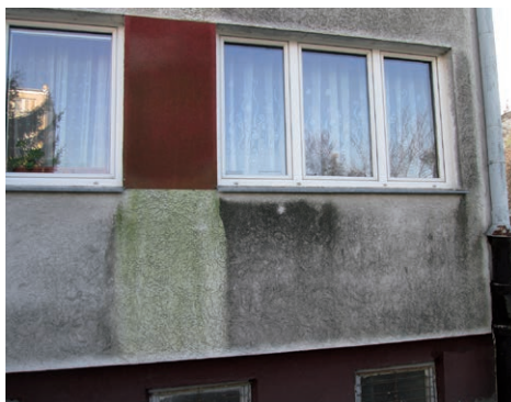
FOT. 24. Ocena stanu zabrudzenia powierzchni tynków – silne zabrudzenie z miejscowym skażeniem mikrobiologicznym; fot. archiwum autora
