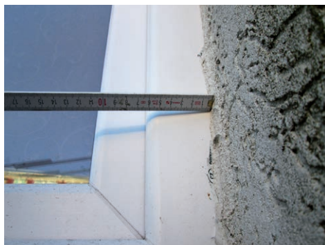
FOT. 21. Określenie szerokości ramy okiennej pod kątem możliwości ocieplenia ościeża; fot. archiwum autora
