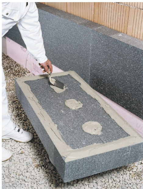
FOT. 3 Nakładanie kleju – metoda obwodowo-punktowa;
