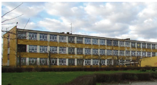
FOT. 1. Budynek szkoły w Końskich przed termomodernizacją;
