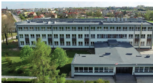
FOT. 2. Budynek szkoły w Końskich po przeprowadzonej termomodernizacji; fot.: ZSP nr. 1 w Końskich
