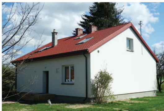
FOT. 4. Budynek jednorodzinny pod Siedlcami po termomodernizacji; fot.: KAPE S.A.
