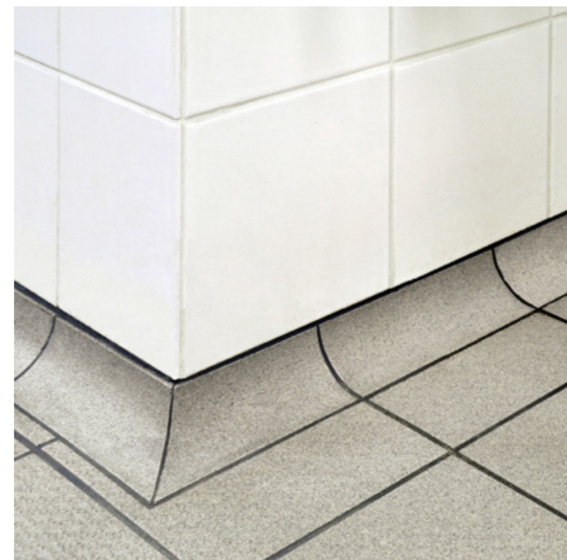
Stadion w Gdańsku – fragment posadzki w trakcie prac
